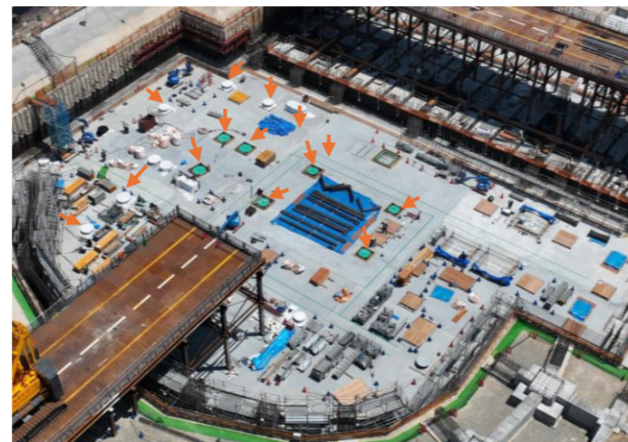
▲ 矢印の部分に免震装置を設置します。
