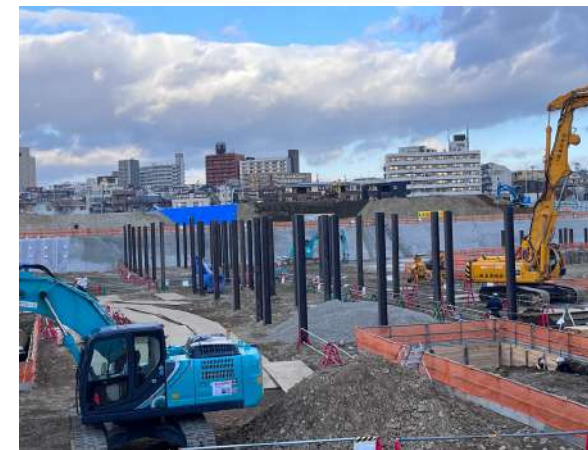
▲構台杭打設状況
