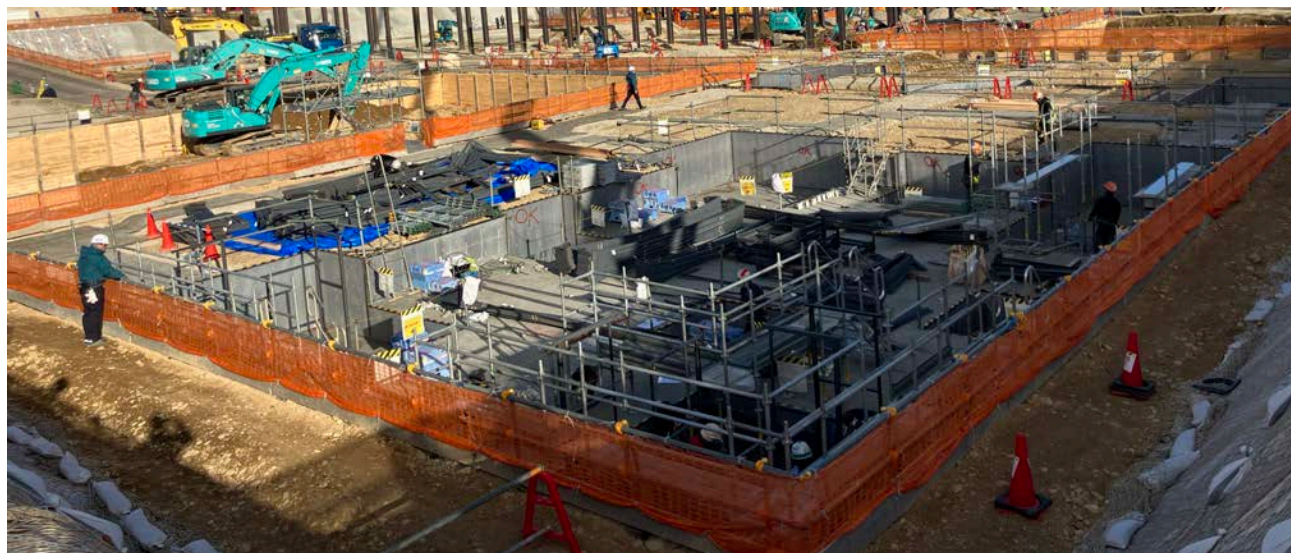
▼鋼製型枠施工状況
