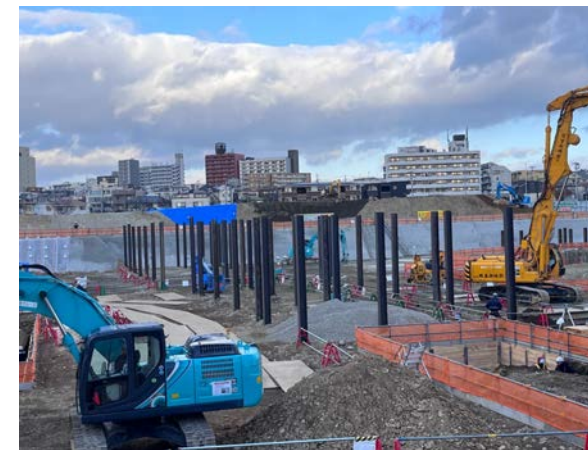
▲構台杭打設状況
