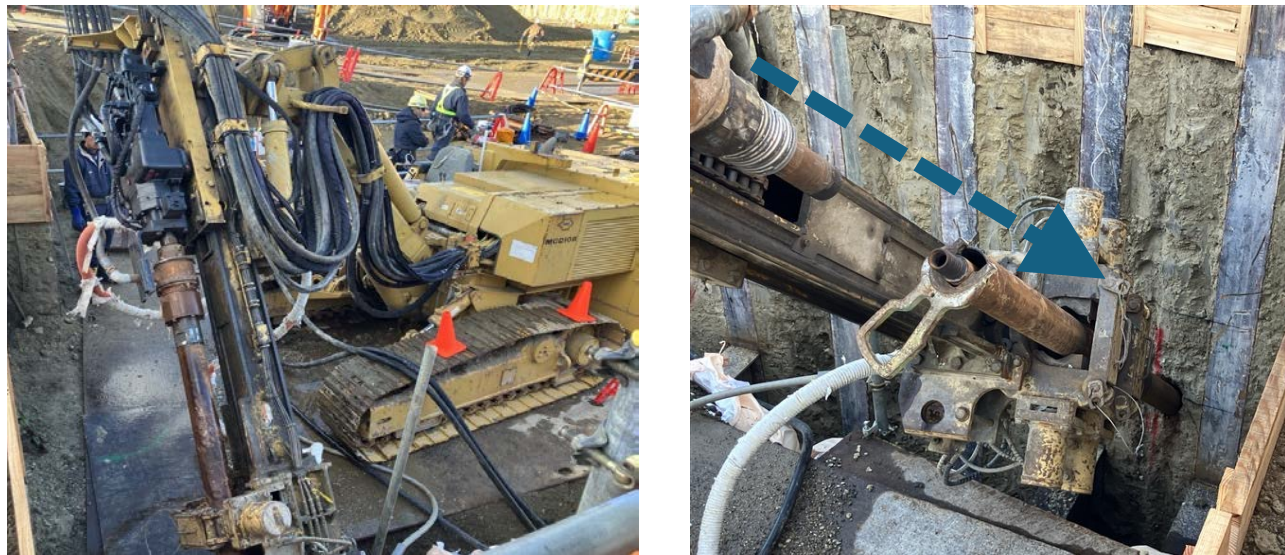
▼アースアンカー打設状況
